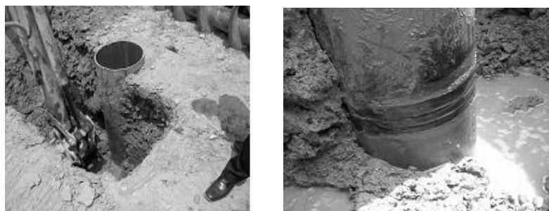
그림 5. HCP말뚝 항타 후 굴착 전경
