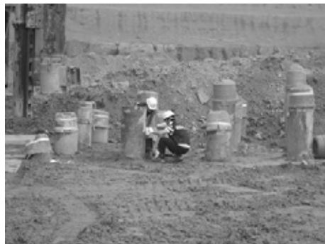
그림 17. 복합말뚝 시공 사례
