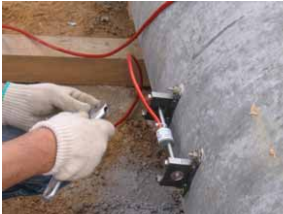
(a) 콘크리트부 Strain Gage 설치
