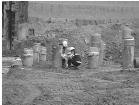
그림 17. 복합말뚝 시공 사례
