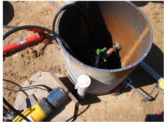
(b) 재하대 설치
