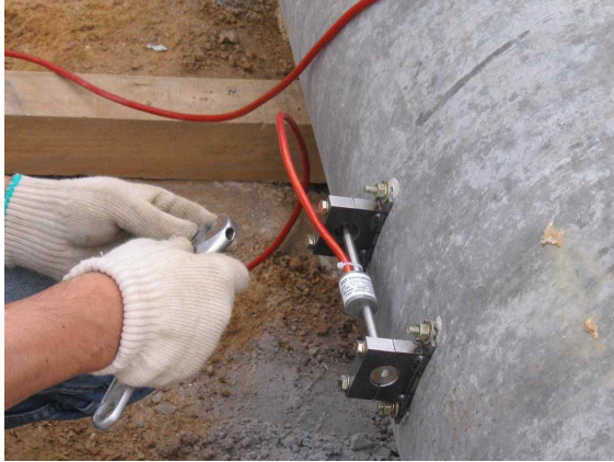
(a) 콘크리트부 Strain Gage 설치
