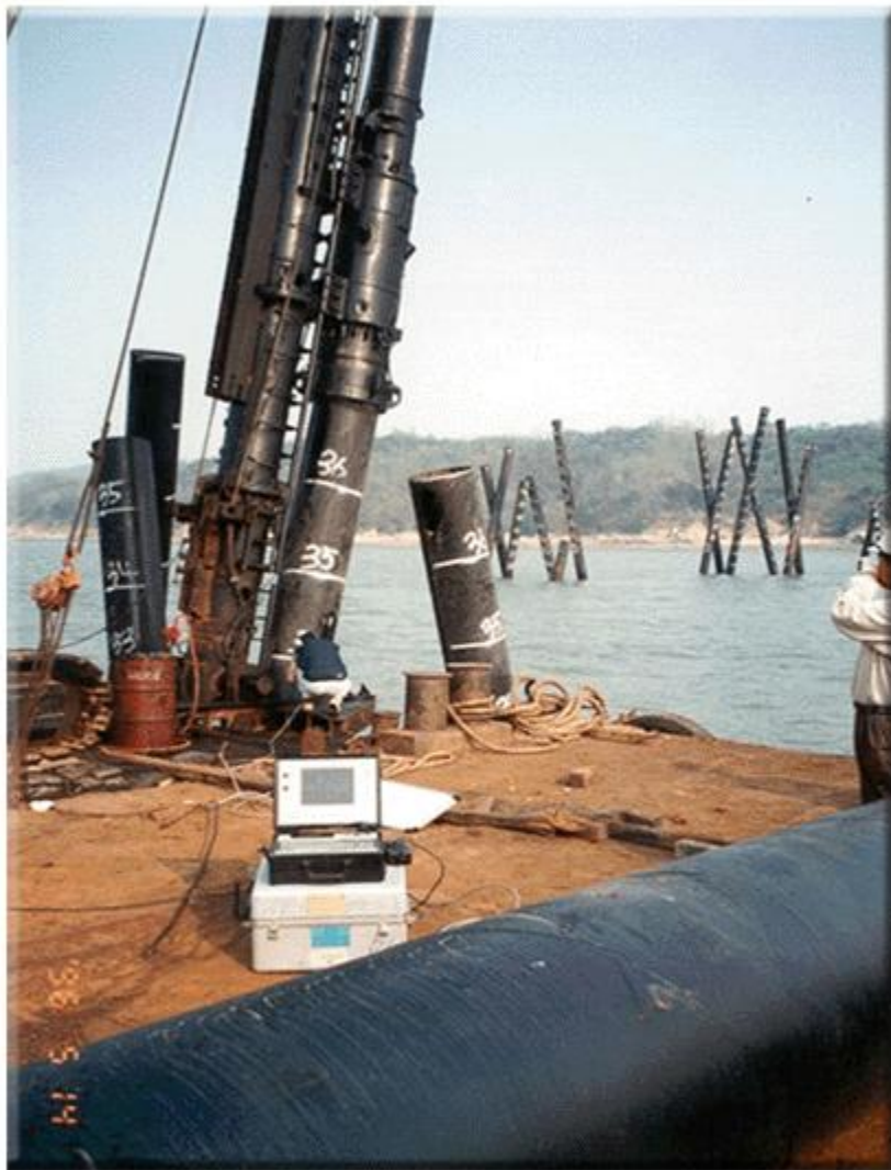
▲ 해상강관말뚝 동재하시험 광경 ▲
